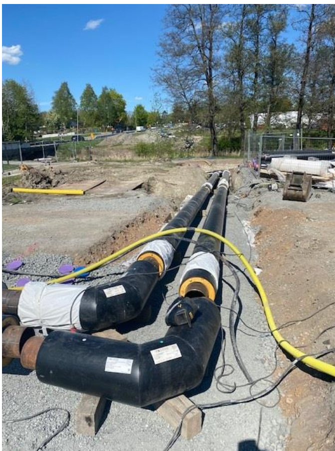
Bild: fjärrvärmerör som läggs i marken.
